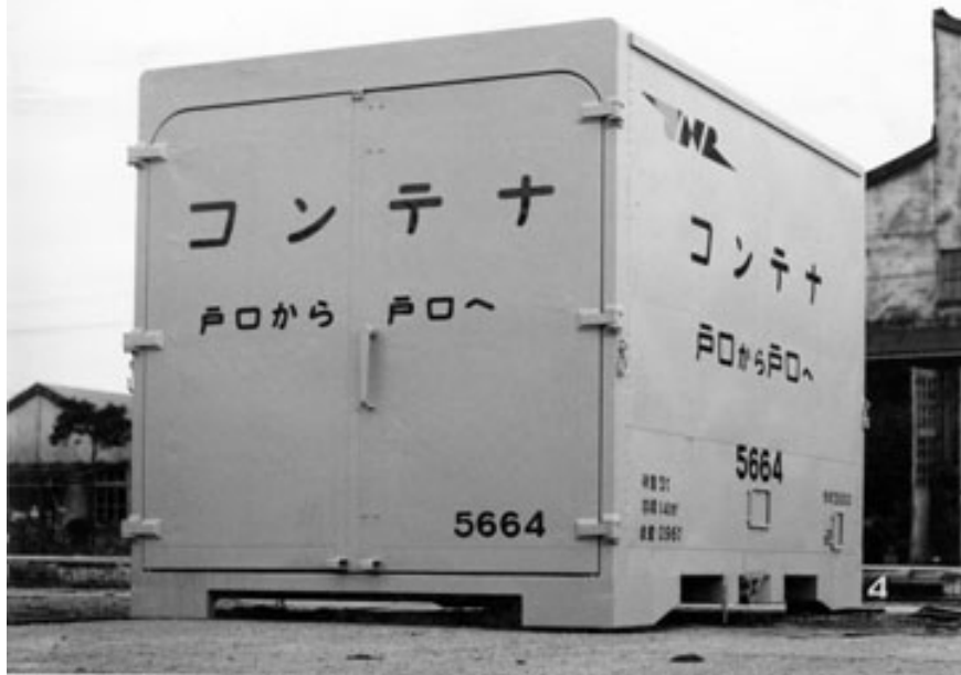
図4. 5000形式 国鉄が考えた新幹線 用コンテナ
